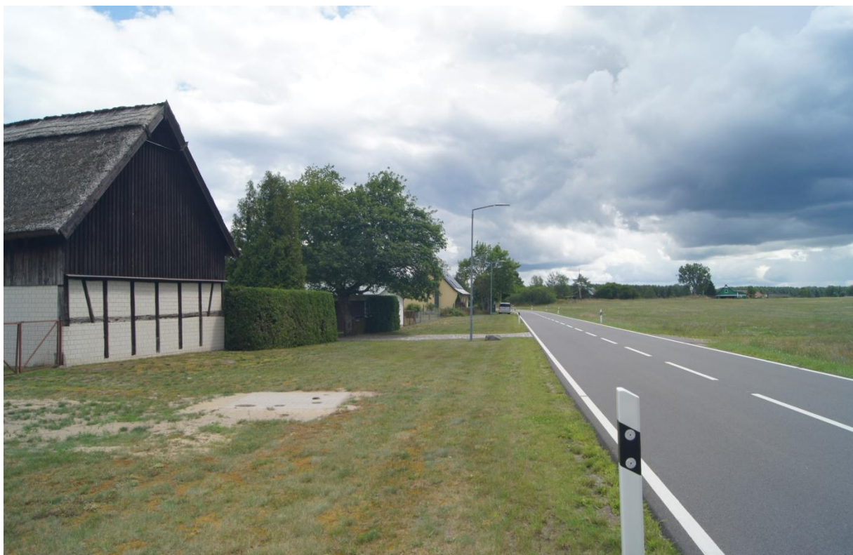
Bild 14 mit Hecken und Einzelbäumen versehene und bebaute Wohnflächen, Blickrichtung Osten
