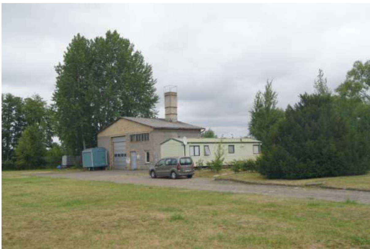
Bild 06 Baufeld 3 vom Süden
