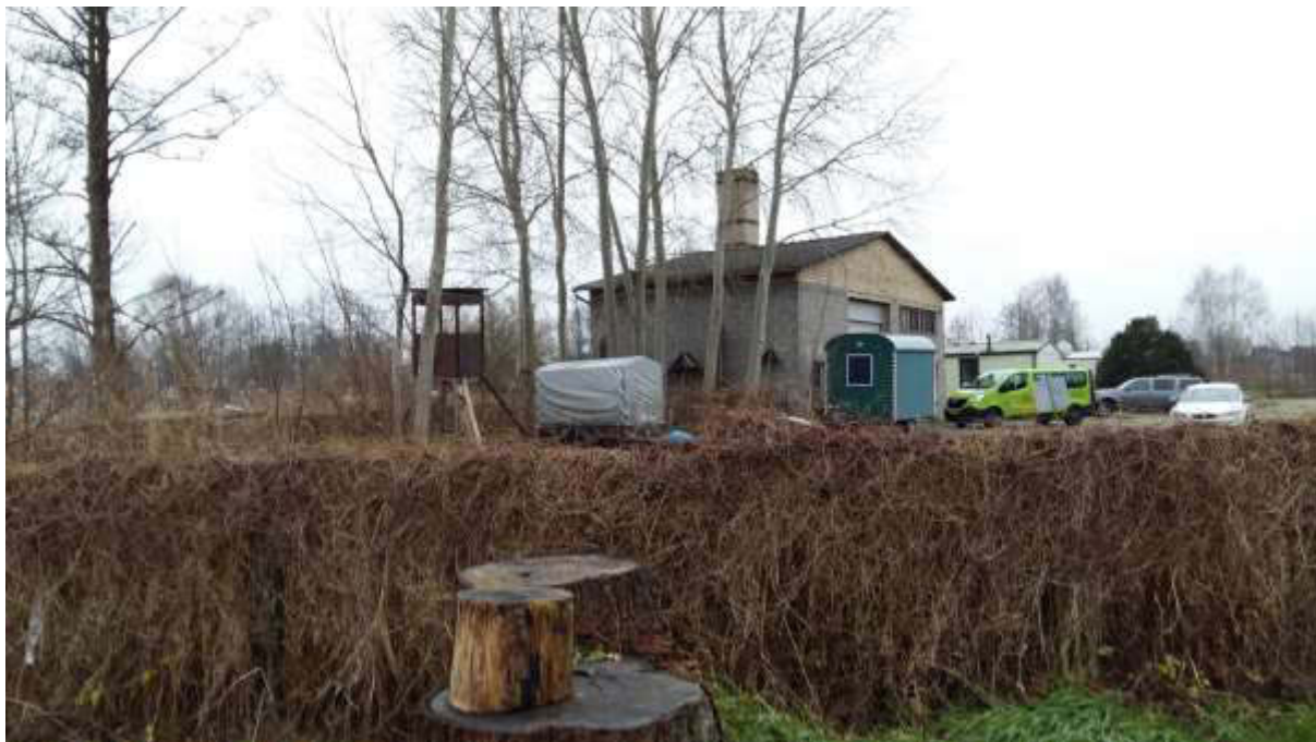
Bild 01 Pappeln und zur Sanierung vorgesehene Gebäude vom Norden
