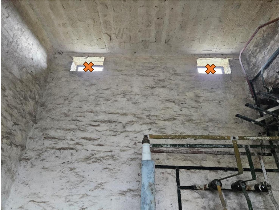
Abbildung 10: Innenansicht Gebäude / Turm Nr.3, Oberlichter müssen verschlossen werden.
