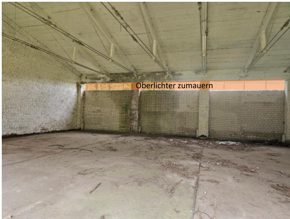
Abbildung 4: Innenansicht Gebäude Nr. 1, südwestliche Wand. Die schmalen Oberlichter müssen ausgemauert werden. So kann der Durchzug im Gebäude verringert werden. Die großen Toröffnungen an der nordöstlichen Gebäudeseite sollen offengelassen werden.
