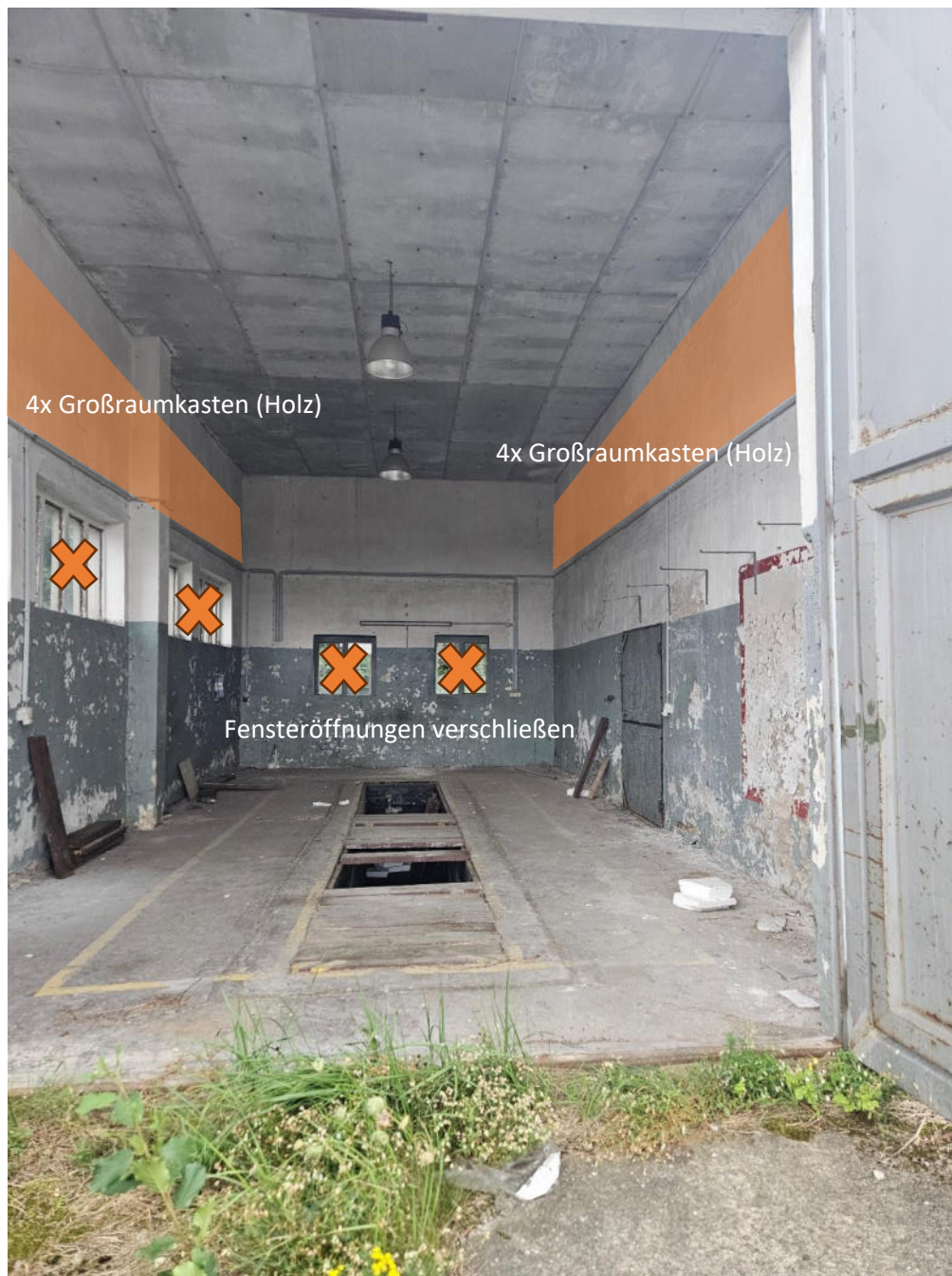
Abbildung 6: Innenansicht Gebäude Nr.2, Montage von 8 Großraumkästen (Holz). Fenster müssen verschlossen werden. Entweder durch ausmauern von Fensteröffnungen oder durch Anbringung von Holz- oder Metall-Platten. Das Tor verschließen und eine ca. 50cm, x 50cm große Öffnungen im oberen Drittel des Tors schaffen.
