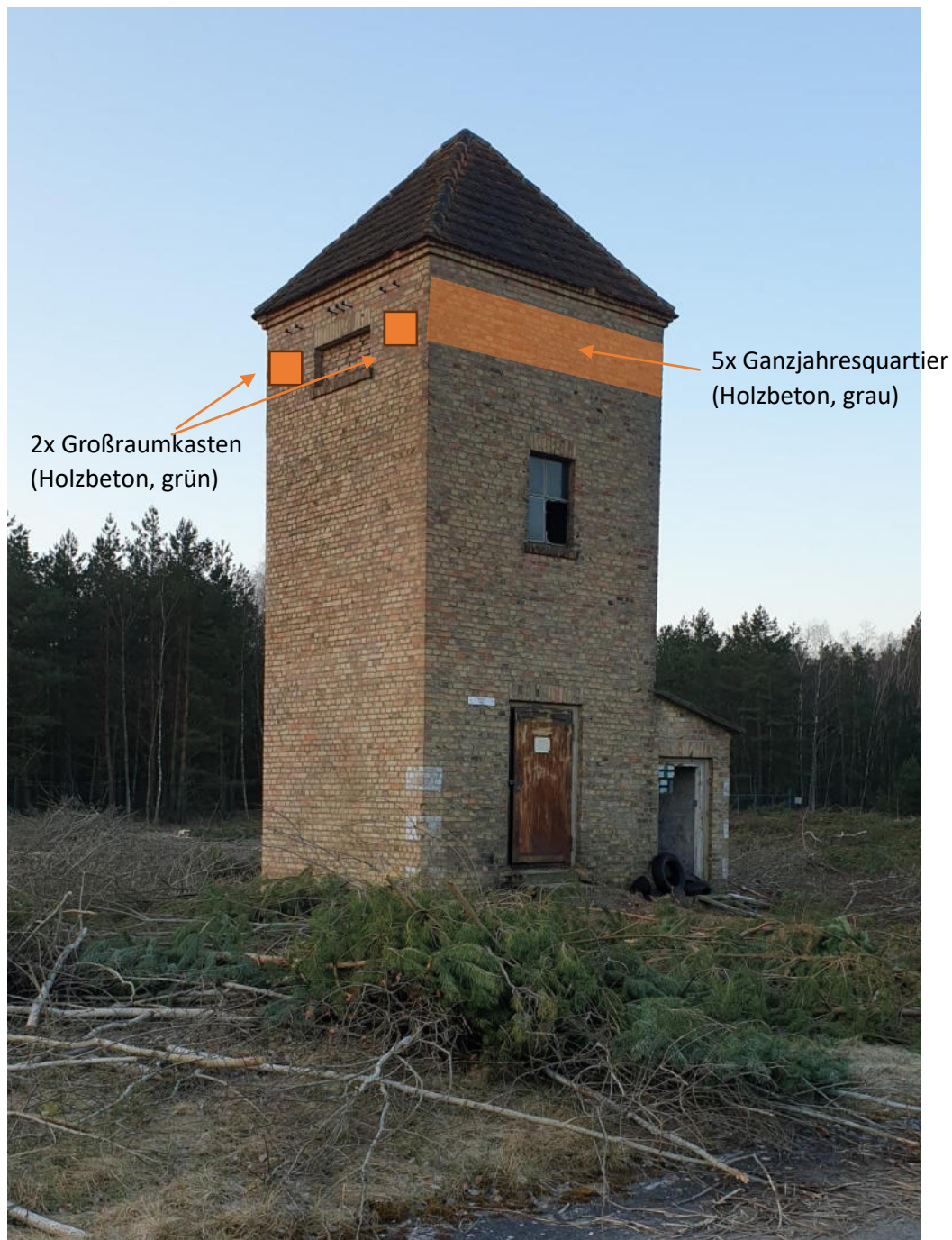
Abbildung 8: Außenansicht Gebäude / Turm Nr.3. Eine Einflugmöglichkeit durch das Fenster ist bereits gegeben. An den Außenwänden werden zwei Großraumkästen (Holzbeton, grün, Aufhängung Metallbügel) und die 5 Ganzjahresquartierskästen (Holzbeton, grau, Befestigung mittels Schrauben) angebracht.
