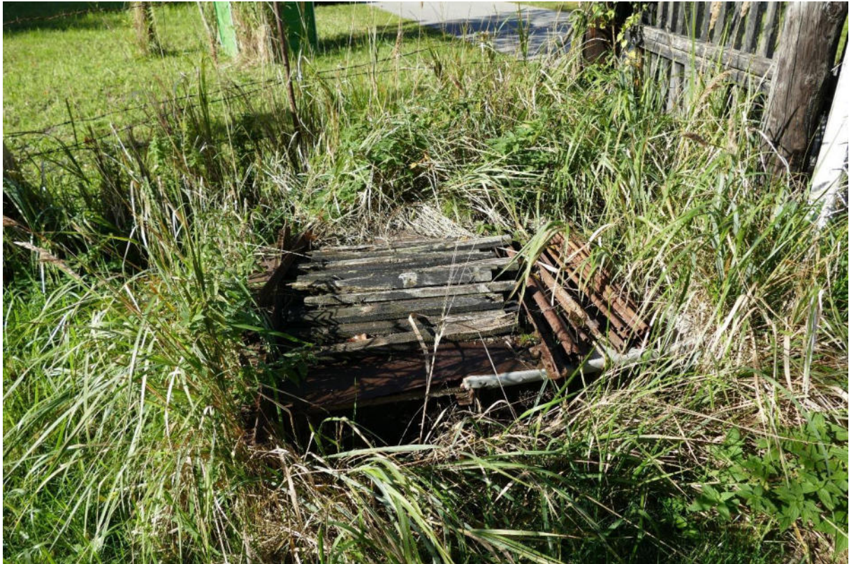
Bild 13 Vermutlich abgedeckter Brunnen (OSS) nordwestlich im Plangebiet
