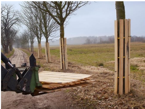
Abbildung 16: Stammschutz zur Anbringung vor Baubeginn (BENNO BAUMSCHUTZ 2023)
