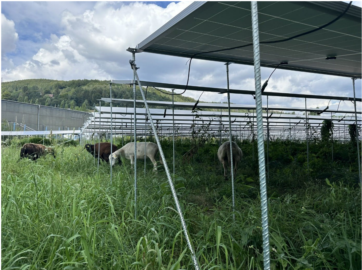
Abb. 3-1: Unterkonstruktion BECU mit Öffnung nach Norden/ Schafbeweidung im Pilotprojekt Sonneberg
