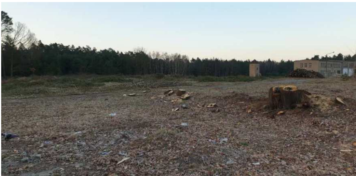
Abbildung 12: Blick über südliche Vorhabenfläche mit gerodetem Baumbestand
