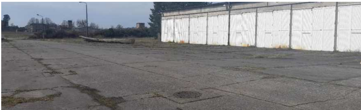
Abbildung 4: große Betonflächen zwischen ungenutzten Gebäuden
